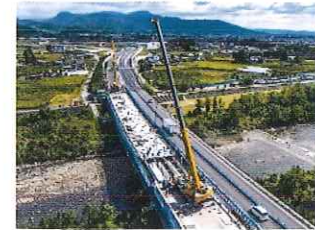
対面通行規制状況
